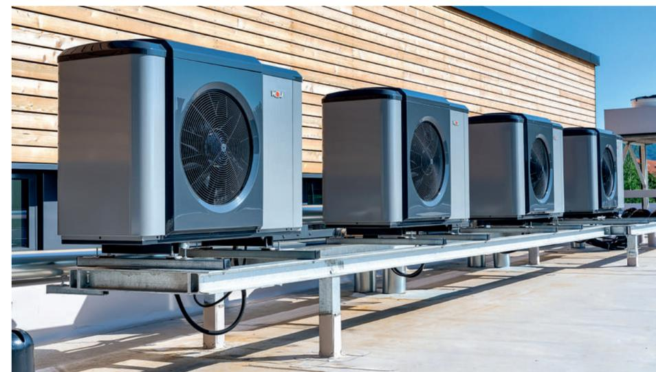
Wärmepumpenkaskade, bestehend aus im Außenbereich aufgestellten CHA-Monoblock-Geräten.
