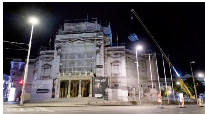
Von Fliegengewichten kann bei den neuen Lüftungsanlagen keineswegs die Rede sein. Über eigens dafür geschaffene Wandöffnungen gelangten die in Summe 13 Tonnen schweren Geräte ins Innere des, im Jahre 1889 gegründeten, Volkstheaters.
