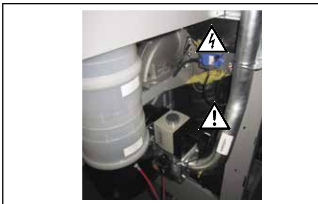
Bild: Zündtrafo, Hochspannungs-Zündelectrode, Gaskombiventil, Gasdruckwächter, Ventilator, Brennkammer Gefahr durch elektrische Spannung, Gefahr von Vergiftung und Explosion durch ausströmendes Gas, Gefahr von Verbrennung durch heiße Bauteile.
