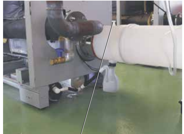
Messöffnung an der Kondensatfalle
