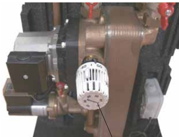
termostatický regulátor s konštantne nastavenou teplotou
