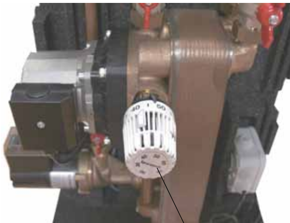
Régulateur thermique à valeur fixe
