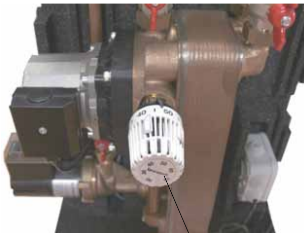
Valvola termostatica acqua sanitaria
