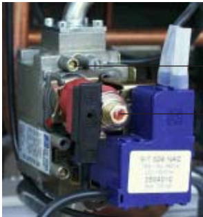
B Meßnippel D Einstellschraube
