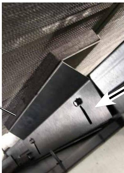
Sind beim RWT Transportsicherungen für die Rotorsegmente eingesetzt, so sind diese ebenfalls zu entfernen.
