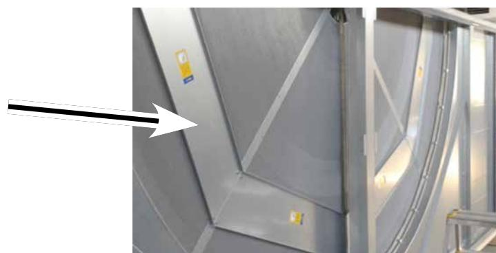
El material para el montaje del recuperador de calor rotativo se almacena dentro de la parte inferior de la carcasa (junto al motor), en el lado de acceso. Con el climatizador se incluye el material para la unión (tornillos, tuercas) dentro del volumen de suministro de este (no en el del recuperador de calor rotativo).
